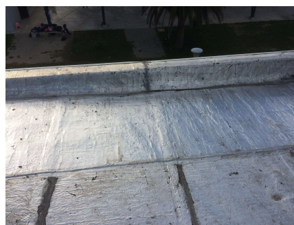
Foto 37 - Reparación de membrana levantada en pretil noreste
