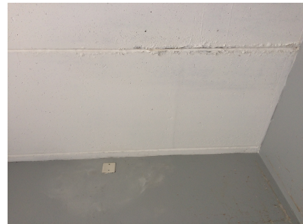
Foto 51 - Filtraciones entre juntas de placas
