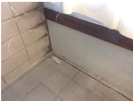
Foto 28 - Desprendimiento de zócalo contra el muro
