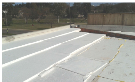
Foto 34 - Colocación de placas de poliestireno expandido
