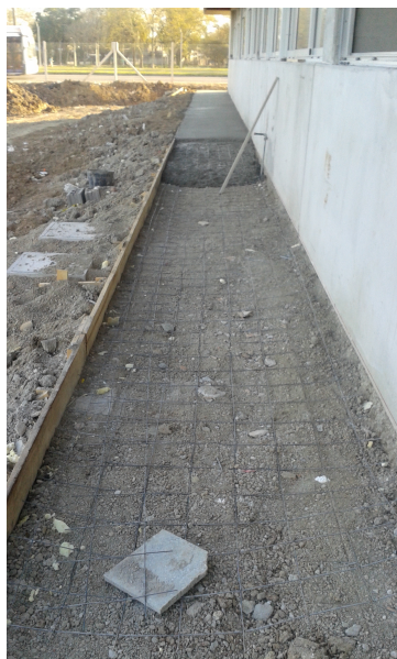
Foto 5 - Encofrado de vereda perimetral
