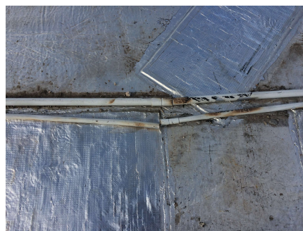
Foto 43 - Ductos eléctricos abiertos
