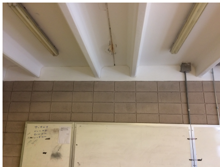
Foto 22 - Filtración entre losas \pi
