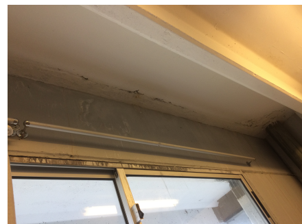
Foto 25 - Extensión de la humedad desde caño de pluviales
