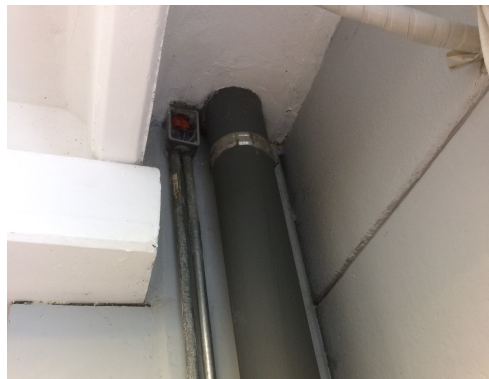
Foto 17 - Ingreso de agua alrededor de caño de pluviales
