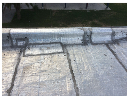
Foto 36 - Reparación de membrana en pretil noreste
