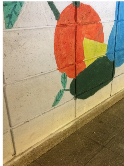
Foto 14 - Fisuración de la junta de la 1ª hilada
