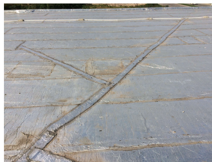
Foto 41 - Reparación de fisura siguiendo una limahoya
