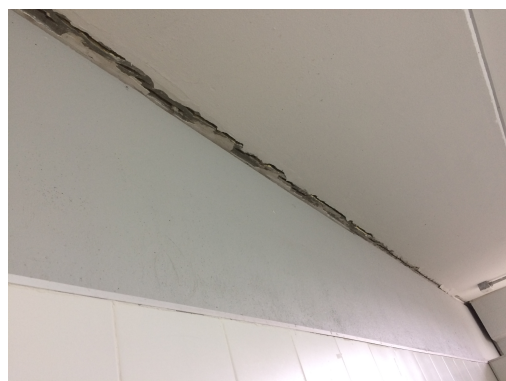
Foto 10 - Separación entre pared noreste y estructura de techo
