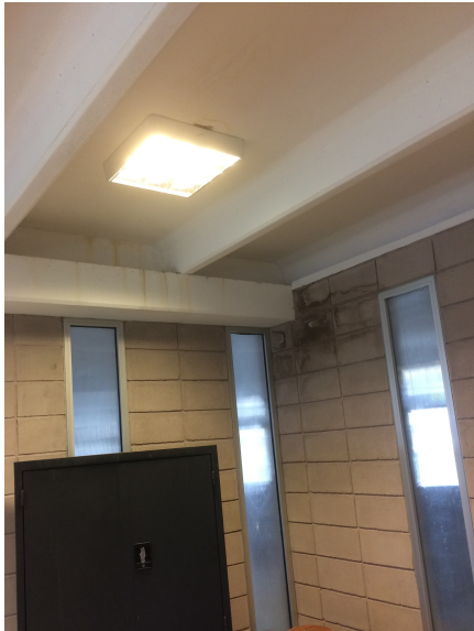
Foto 20 - Filtración en la zona de apoyo de losas
