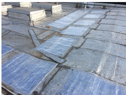
Foto 40 - Reemplazo de camineros por refuerzos de membrana
