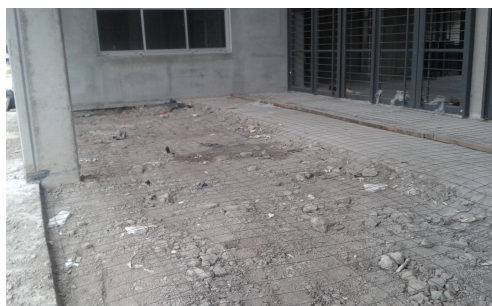
Foto 3 - Acceso, colocación de armadura en el resto
