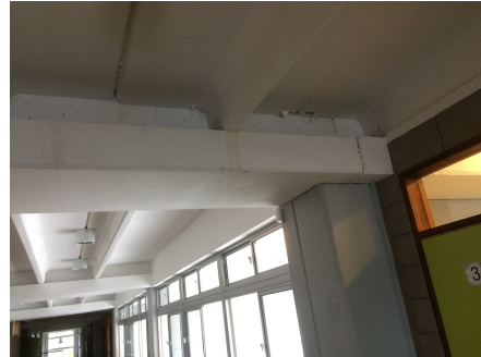
Foto 33 - Ingreso de agua por apoyo de losas \pi
