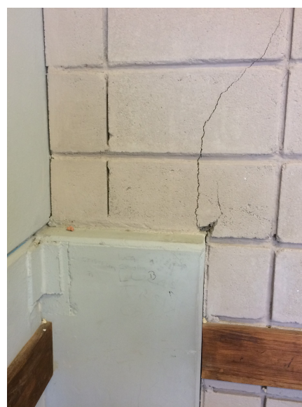
Foto 27 - Detalle de separación y fisuración del muro
