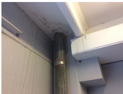
Foto 24 - Ingreso de agua alrededor de caño de pluviales
