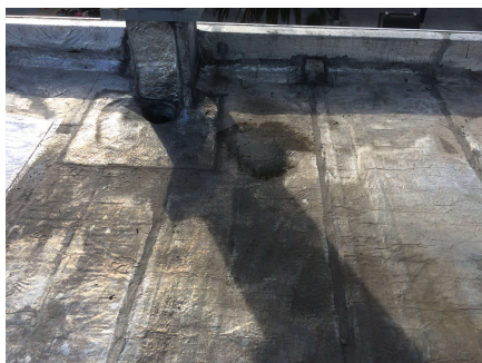
Foto 38 - Reparación cerca del desagüe
