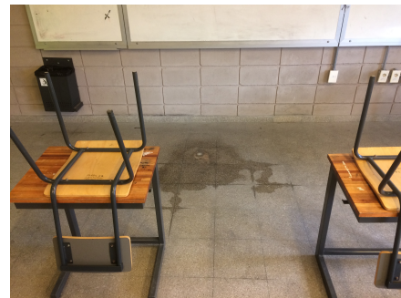
Foto 23 - Agua en el piso por gotera
