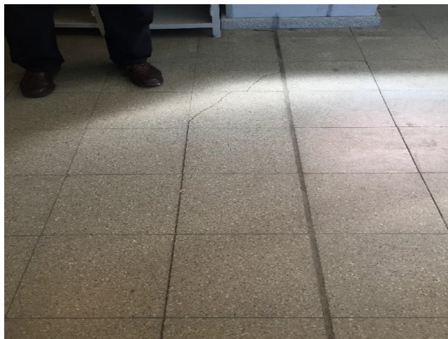
Foto 47 - Junta trabada en pavimento de corredor de P.B.
