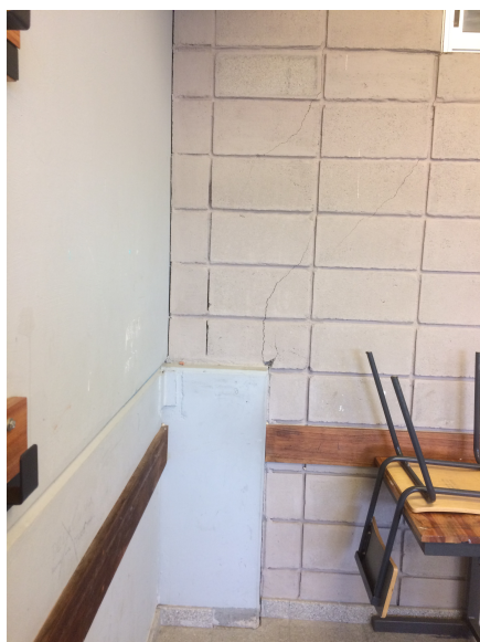
Foto 26 - Separación del muro de bloques, de estructura
