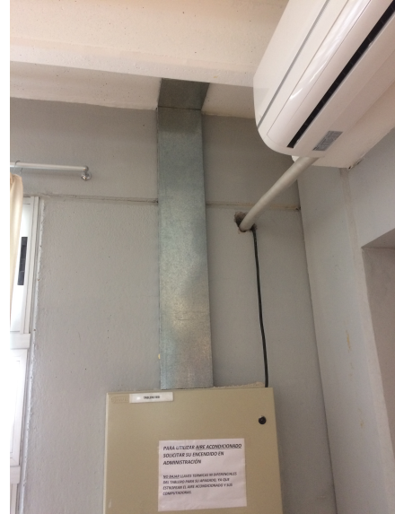
Foto 21 - Filtración por ducto de tablero eléctrico
