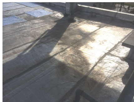
Foto 39 - Empozamiento del agua cerca del desagüe
