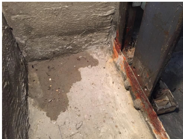
Foto 46 - Mancha de humedad en la esquina norte del foso del ascensor
