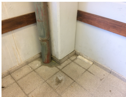
Foto 29 - Desprendimiento de zócalo contra caño de pluviales
