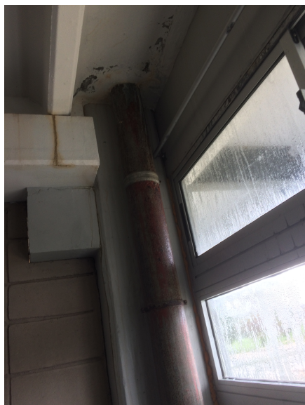
Foto 30 - Ingreso de agua alrededor de caño de pluviales
