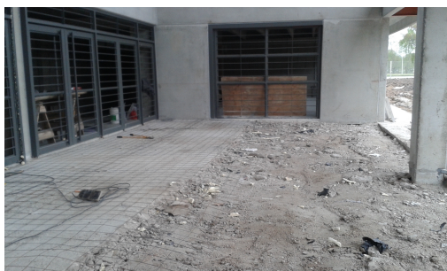
Foto 2 - Acceso, colocación de armadura en 1/2 base
