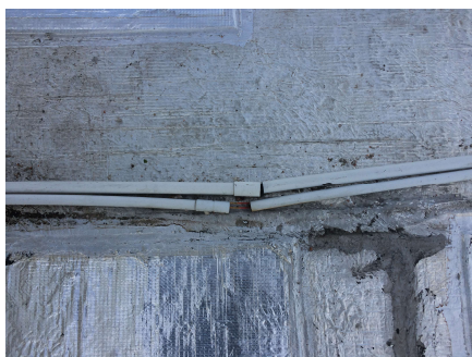
Foto 42 - Ductos eléctricos abiertos
