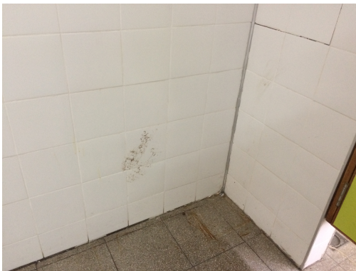
Foto 9 - Separación entre pared noreste y pavimento
