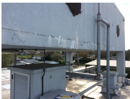
Foto 44 - Manchas de carbonatación por filtraciones al SE
