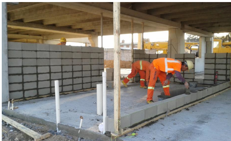
Foto 15 - Levantamiento de muros de bloques en P.B.
